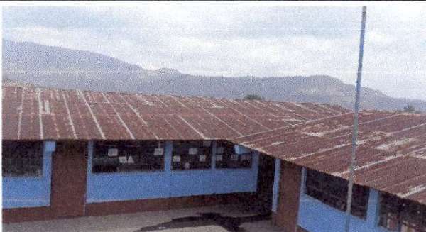
Foto 3: Pintura en muros exteriores e interiores
