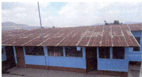
Foto 1: Sustrución de lámina, por lámina troquelada aluzinc
