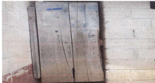
Foto 2: Sustrución de puerta
