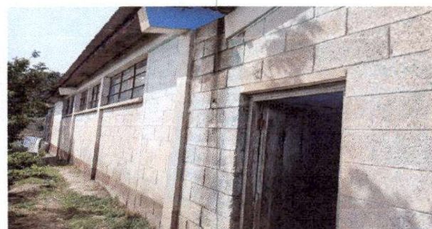
Foto 8: Repello en muro
